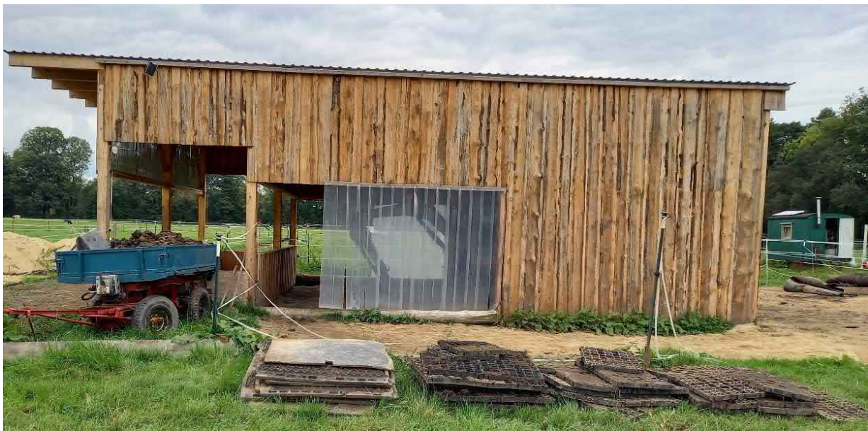
Abb. 1: Offener, für die Pferde frei zugänglicher Unterstand am Standort
