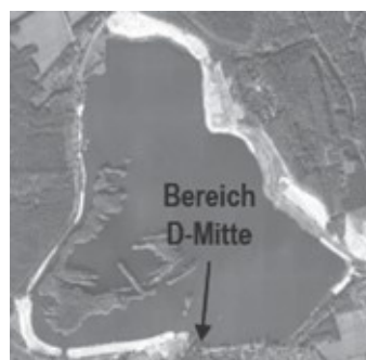
Bereich D-Mitte: Die Arbeiten beginnen demnächst und sollen bis Dezember 2021 fertig gestellt sein.
