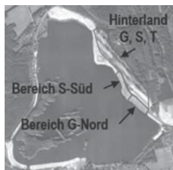
Aufgrund des Ereignisses ruhen hier die Arbeiten. Laut Auskunft der Sachverständigen befindet sich die Situation in einem grenzstabilen Zustand. Es kann keine Gewährleistung dafür übernommen werden, dass es nicht noch weitere Abbrüche geben kann. Es finden daher aktuell Monitoring und Erkundungsmaßnahmen statt, um dies frühzeitig zu erkennen.
